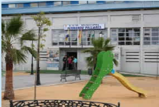
Edificio de usos múltiples de reciente construcción
