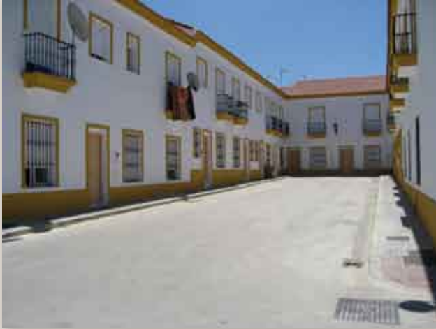
Las calles de los nuevos trazados viarios, que forman parte de los primeros crecimientos del núcleo de una de las localidades analizadas
