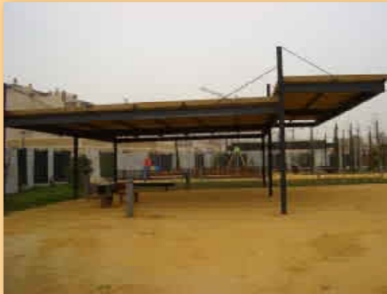
En algunos de los nuevos crecimientos residenciales se han construido espacios libres y para el ocio
