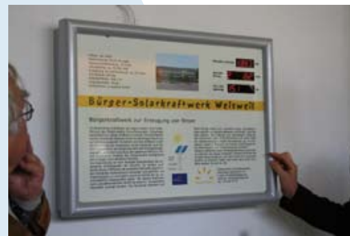
CONTROL ENERGÉTICO EN LAS AULAS. Panel de control de balance energético en un colegio. Suministra información instantánea sobre la energía consumida y generada por el edificio, convirtiéndose en elemento ilustrativo de educación ambiental.
