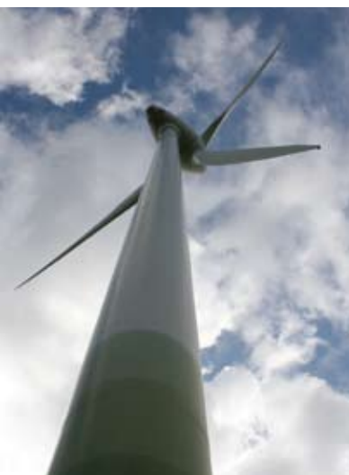
PARQUE EÓLICO COOPERATIVO. Uno de los cuatro generadores que componen un parque eólico propiedad de 100 vecinos de la zona, una fórmula de gestionar este tipo de energía muy distinta a la española.
