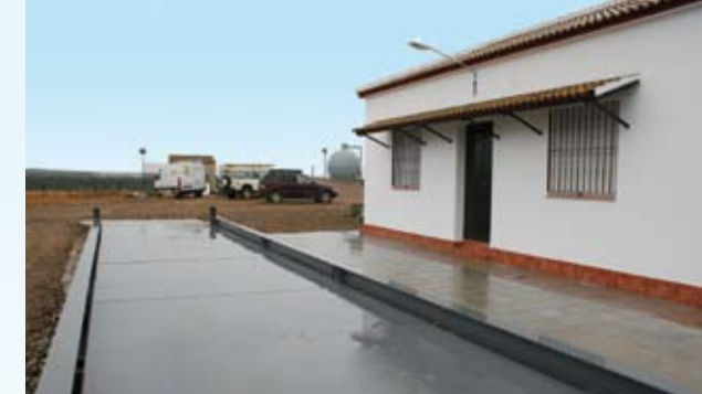
BÁSCULA. En ella se recepciona y pesa el material, y también se observa su limpieza. Junto a la báscula están las oficinas de la planta de Ecoreciclaje Doñana.
