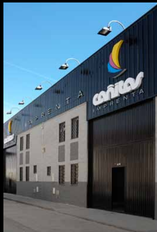
Fachada de las nuevas instalaciones en el Pg. Ind. Pílasur
