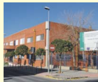
Obras de reforma en el CEIP Carlos I en Dos Hermanas (FEDER)
